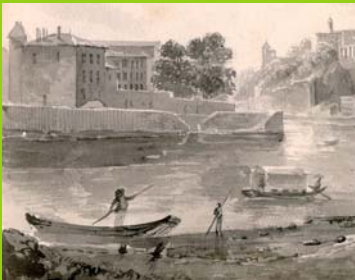
Vue, depuis le quai Bourgneuf, sur Sainte-Marie-des-Chânes 19 e siècle
