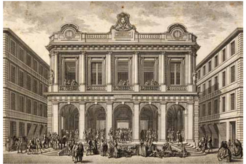
Loge des Changes de Lyon, construite sur les dessins et sous la conduite de J.G. Soufflot, dessin, Jean-Baptiste Roche, 1749, Inv. N 3830
